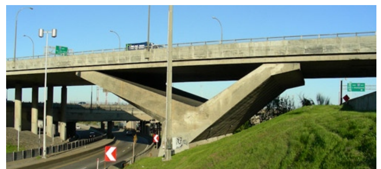
Viaduc rue Saint-Jacques - 1967
